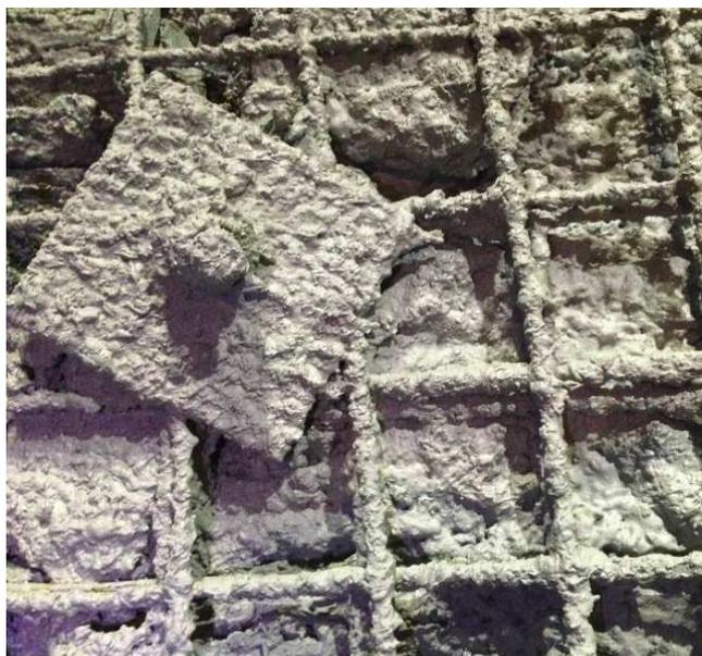
TamCrete SSL – материал на полимерной основе, предназначенный для возведения тонких структурных крепей. Его основными компонентами являются акрилатный полимер и тонкий фракционированный наполнитель.
