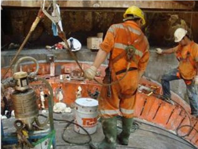
TamPur 130 / TamKat 130 это однокомпонентный тампонажный материал, основанный на смеси метилен-дифенил диизоцианата, полиэфиров полиолов и аминовых катализаторов. Система начинает реагировать при контакте с водой, образуя полу-эластичную пену.
