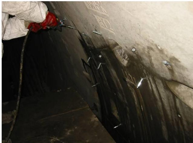
TamPur 150 это однокомпонентный гидрофильный полиуретан в комбинации с полиэфирными полиолами. Реагирует лишь при смешивании с водой и по окончании реакции образует эластичный герметизирующий материал.
