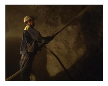
TamShot 80 PAF бесщелочной высокоэффективный порошковый ускоритель схватывания и твердения, применяемый для возведения набрызгбетонной крепи по технологии сухого способа.
