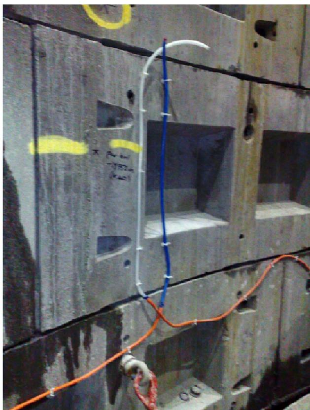
Tam Injection Tube RI был специально разработан для распределенного равномерного тампонирования в швах (по площади контакта конструкций) или на границе конструкции с породой для предотвращения и остановки водопроявлений.
